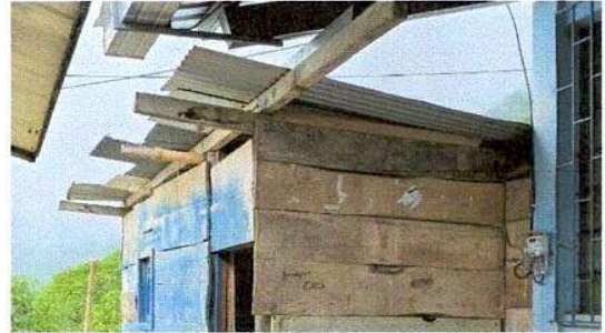
Foto 2: 2.2. Sustitución de estructura de soporte de madera, por metal en aula
