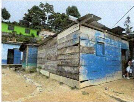
Foto1: 1.1. Sustitución de lámina, por lámina troquelada aluzinc calibre 26 en aula
